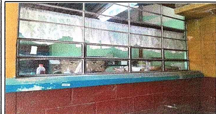
Foto 3 : Sustitucion de ventanas
