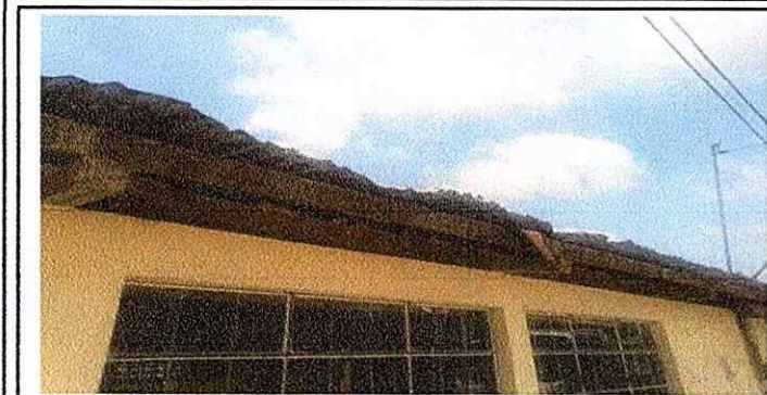
Foto 1: Sustitucion de techo
