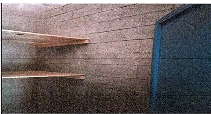
Foto 6 : Sustitucion de gabinetes
