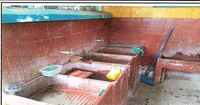
Foto 2 : Sustitucion de pila con tanque
